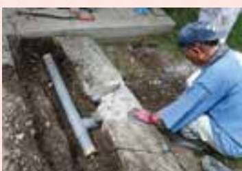
排水処理 作業
