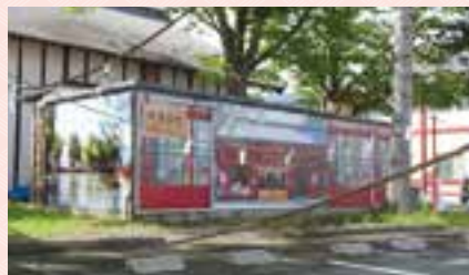
ダルマ倉庫シール貼り付け
